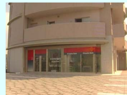
20年9月 名取ローンステーション新設
