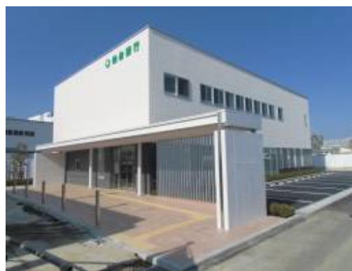
新・苦竹支店（平成 25 年 11 月）
