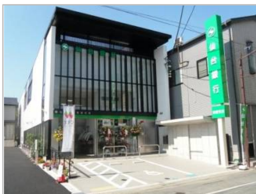
新・塩釜支店（平成 25 年 7 月）
