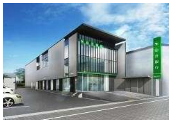
新・塩釜支店（平成 25 年 7 月）
